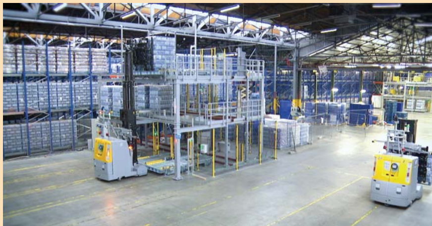
O portfólio do E80 Group inclui armazéns automáticos de alta densidade com shuttles ou transelevadores que interagem com veículos automáticos guiados a laser e com todo o sistema
